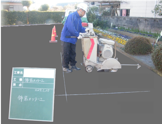
工事着手前（舗装切断工）
