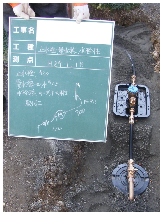
敷地内配管状況
