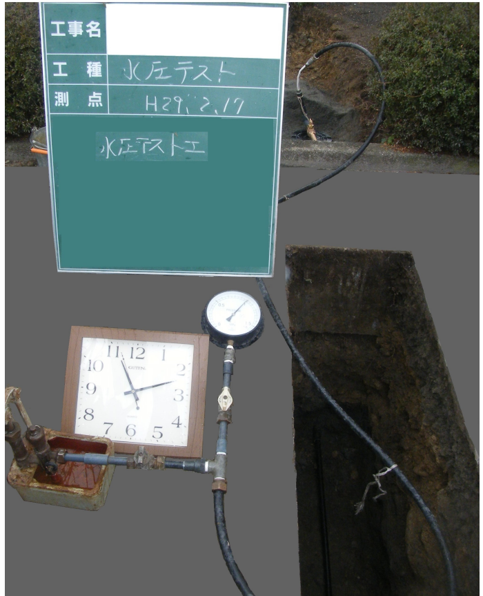
耐圧テスト確認状況
